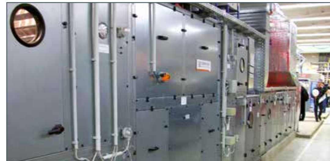
évaporateur direct comme refroidisseur d'air
