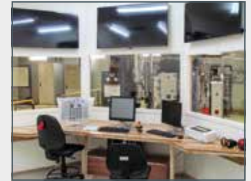
Module D Poste de commande
