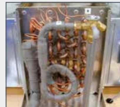
évaporateur direct comme refroidisseur d'air
