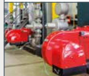
Chaudière de chauffage au fioul, au gaz ou au bois
