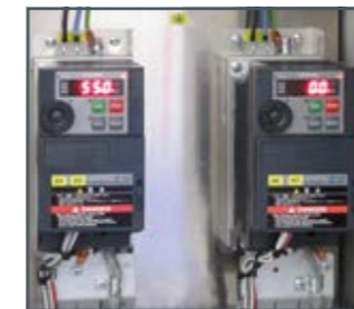
Convertisseurs de fréquence pour contrôler les pompes
