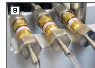
Raccordements pour biogaz sans analyse de gaz
