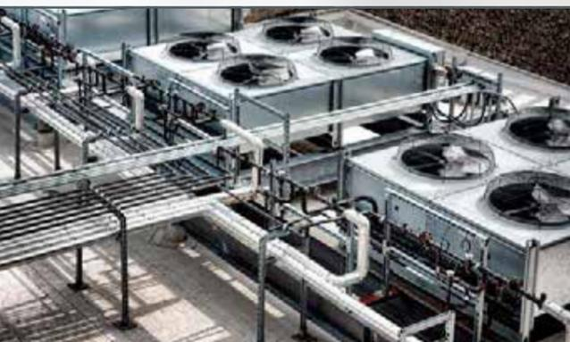
Condenseur dans un réseau de conduites d'agent réfrigérant
