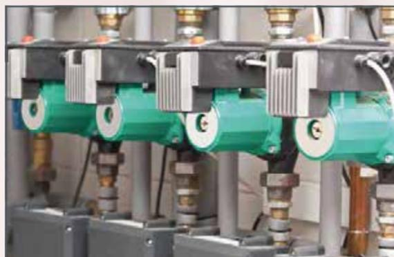
Les pompes de circulation ultra-performantes utilisées pour le chauffage fournissent la même puissance que les pompes traditionnelles tout en consommant jusqu'à 80% d'électricité en moins.
