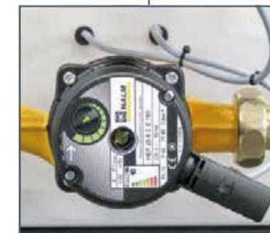
Pompe de circulation énergétiquement efficace avec régulation de la pression différentielle réglable (classe d'efficacité A)
