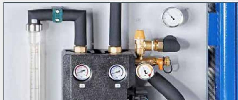
Le panneau du circuit solaire comprend une pompe de circulation et des composants essentiels à la fiabilité de fonctionnement.
