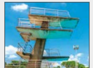
Exemple de charge de flexion d'une poutre fixe sur un seul côté: le plongeur
